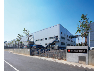
【대만】오야츠 컴퍼니 타워위안 공장
